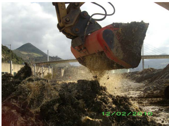
Fig. 39. Pala Allu realizando la mezcla
